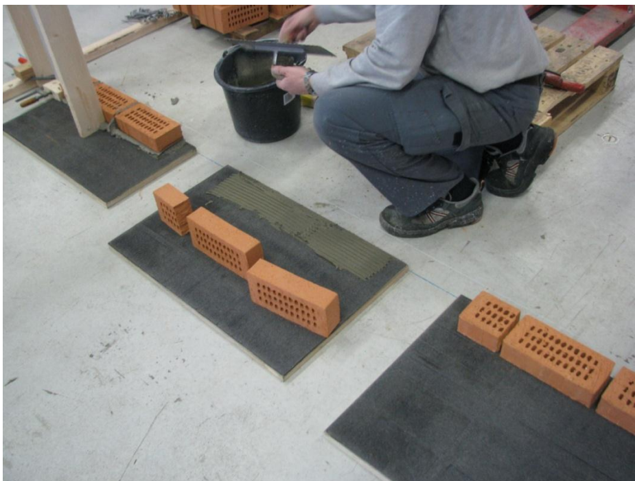
Fig. 7. Opmuring af bagmur startes på sædvanlig vis. Eventuelt vælges en lim-pap-lim løsning i bund for at forøge forskydningskapaciteten mod sokkel
