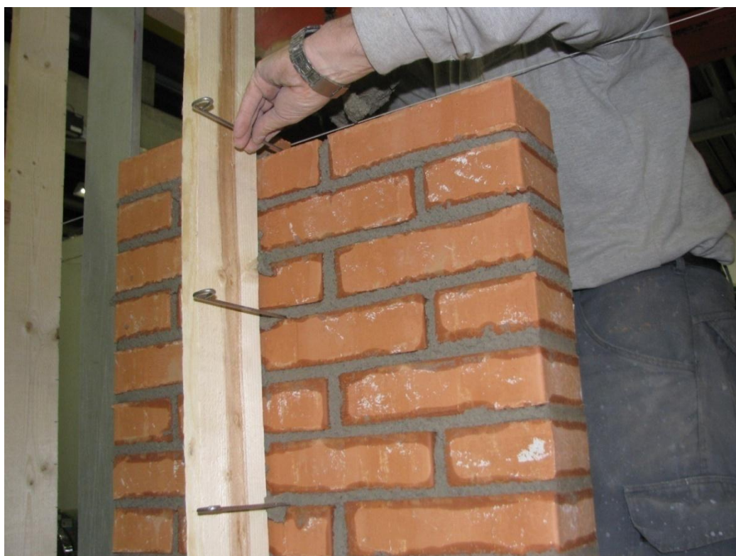
Fig. 10. I den resterende del af væggen højde indsættes 1 binder pr 3. skifte. 1 binder gælden- de for en vægbredde op til 0,96 m eller 4 sten. Ellers 1 binder pr 0,96 m/4 sten
