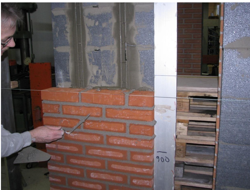
Fig. 25. Fugerne skræbes og trykkes på sædvanlig vis efter opmuringen
