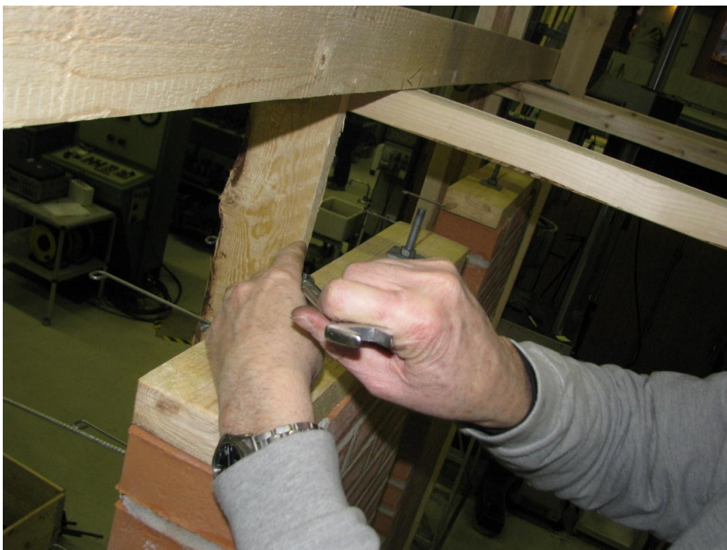
Fig. 13. Rem monteres med spændeskive og møtrik
