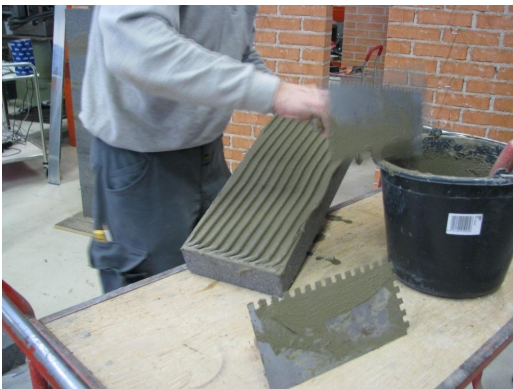
Fig. 16. Påsmøring af Multiklæb
