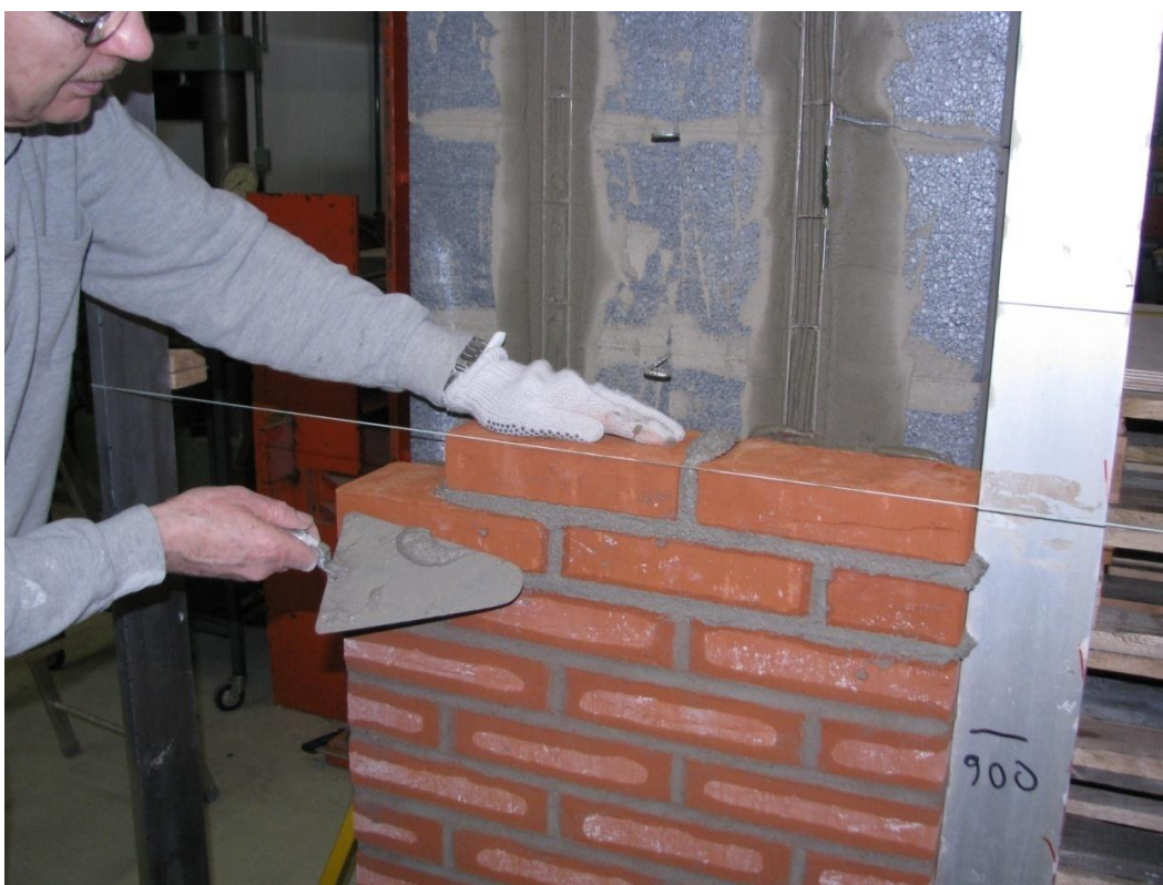
Fig. 24. Formuren opføres inden, Multiklæb på EPS er hærdnet helt op
