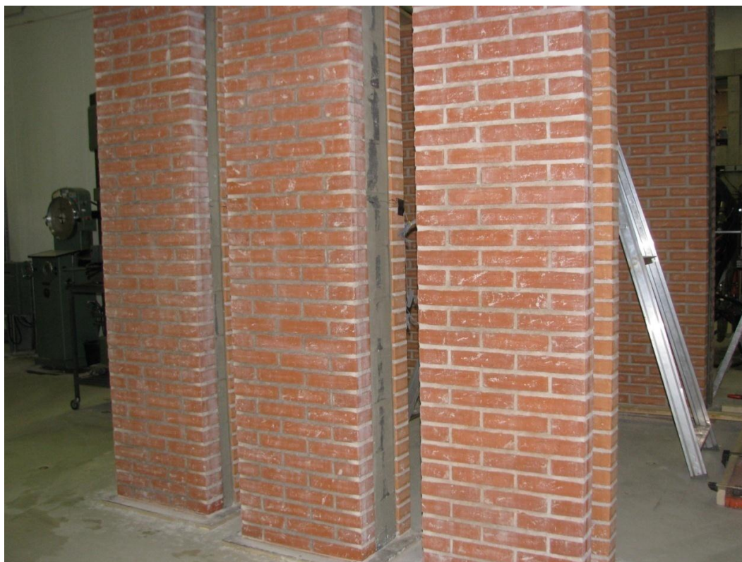
Fig. 26. Bemærk formuren kan være længere tid om at hærde og tørre ud end normalt, da dette kun kan foregå fra 1 side mod normalt 2 (væg til højre er uden EPS).
