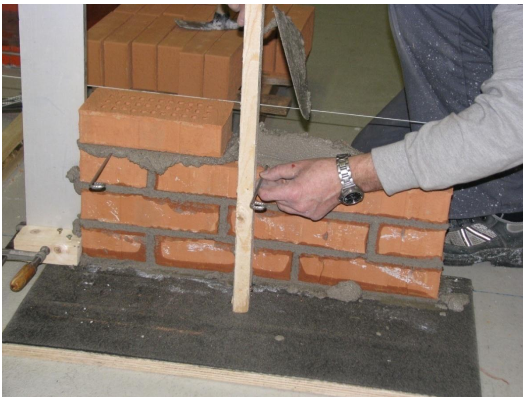
Fig. 9. Ved bund og top indsættes 1 binder pr sten i 3. skifte fra bund og top. For den viste væg er dette 3 bindere i de aktuelle skifter
