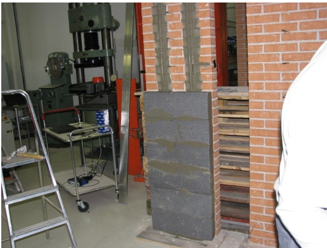
Fig. 15. EPS-blokkene påsmøres lim i liggefuge, på bagside og trykkes mod bagvæg (vådt i vådt). Der anvendes tandspartel eller andet egnet værktøj
