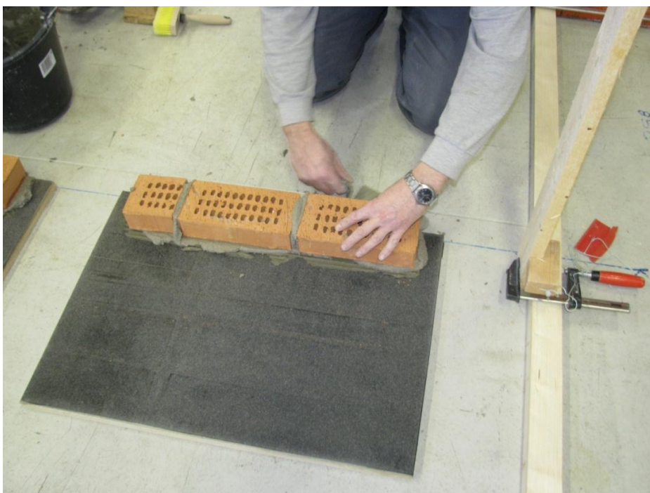
Fig. 8. Opmuring af 1. skifte
