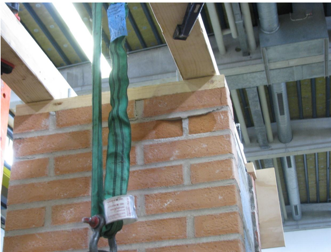
Fig. 4. Forskydningsbrud i top
